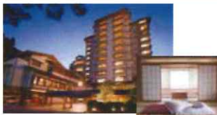
石川県和倉温泉「加賀屋」 全室に導入されました。
